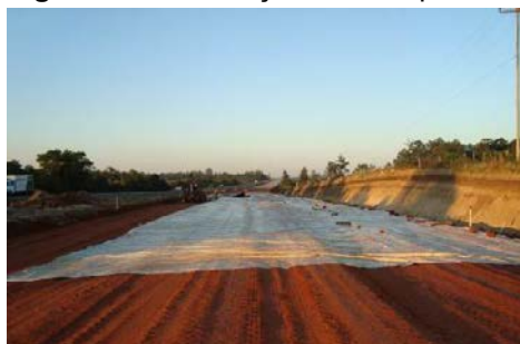
Figura 10 - Colocação de lona plástica.
