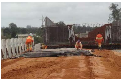
Figura 12 - Colocação da lona plástica.
