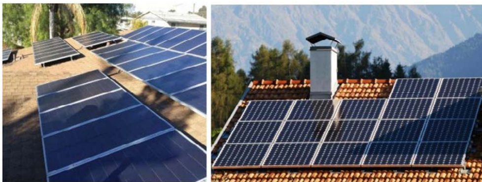
Figura 1 – Sombreamento por árvores (figura à esquerda) e por construções vizinhas (figura à direita)
