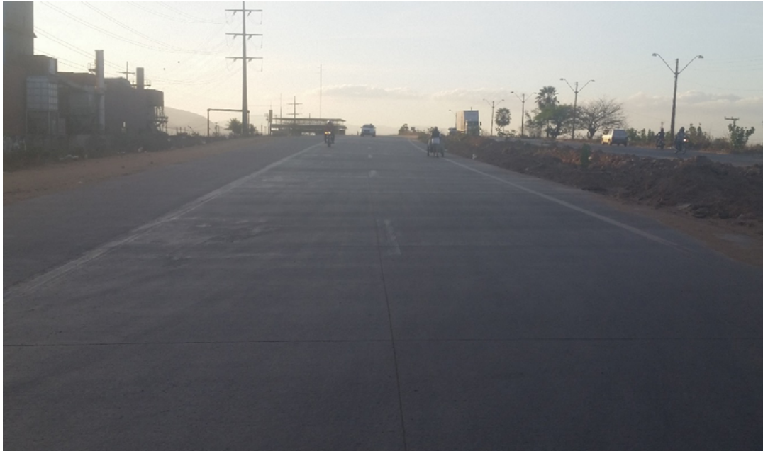
Figura 6: Av. Quarto Anel Viário, pavimento executado – Trecho 2
