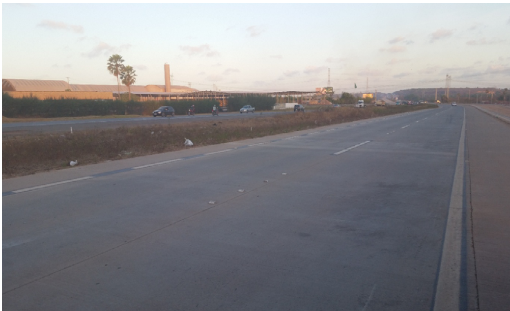
Figura 5: Av. Quarto Anel Viário, pavimento executado – Trecho 1
