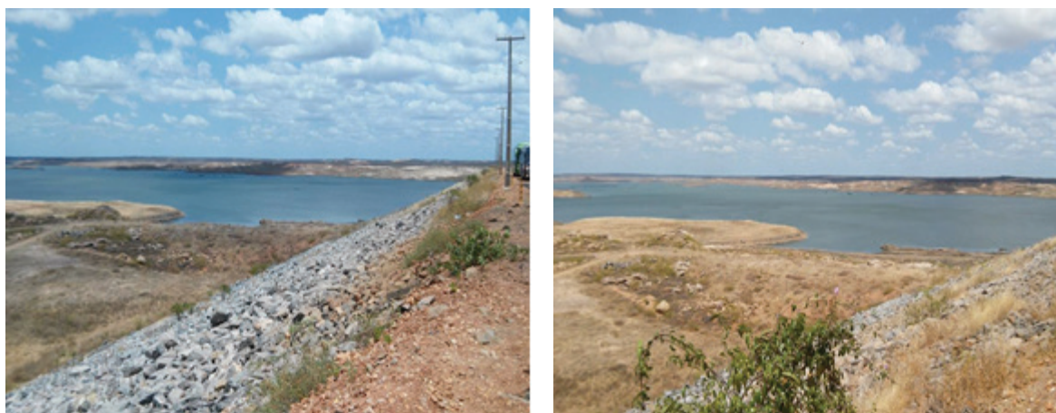
Figura 4 – Reservatório Castanhão (a e b)
