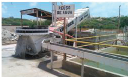
Figura 06: Reuso da água na recicladora de concreto.
