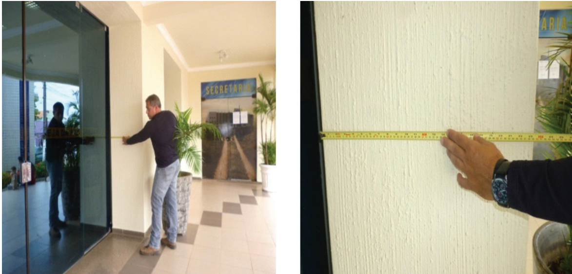
Figura 2 – Espessura da alvenaria externa do templo (Fotografia: Manoel Cruz – acervo pessoal)
