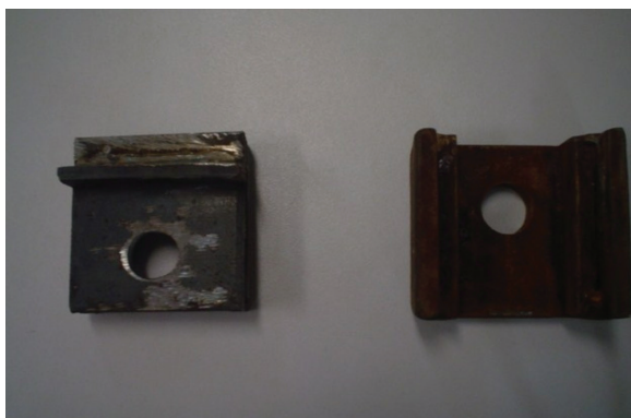
Figura 13: Junções de fixação da chave fusível com duplo isolamento.
