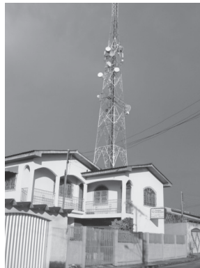
Figura 5: ERB instalada na Av. Ceará, no Centro da Cidade
