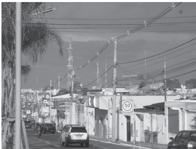
Figura 7: ERB's integrando a paisagem da Av. Ceará, sentido Bairro-Centro
