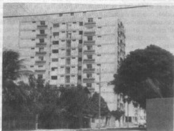
FOTO 9: RUA TORRES CÂMARA - LADO SUL
