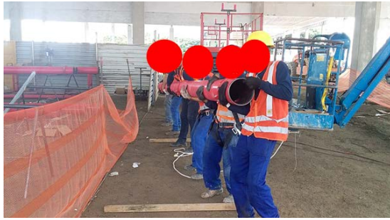
Figura 3 – Transporte vertical de tubulação de 8" de forma manual
