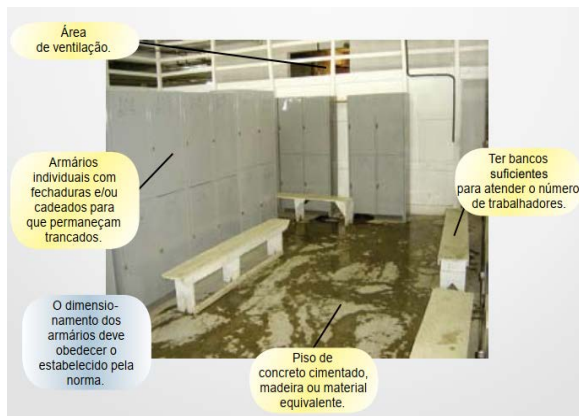
Figura 27 – Exemplo de vestiário2 atendendo às exigências da NR-18
