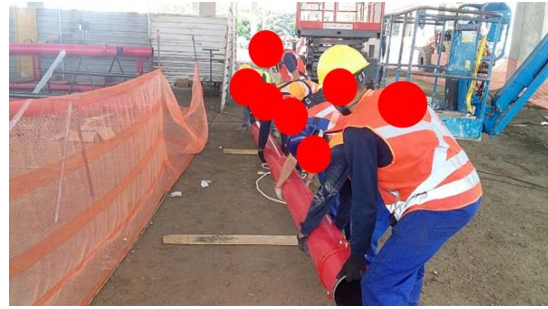
Figura 4 – Trabalhadores agachados para posicionar o tubo no piso
