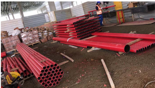
Figura 15 – Oficina de preparo de tubulações
