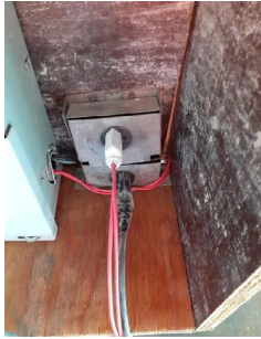
Figura 13 – Cabos desprotegidos
