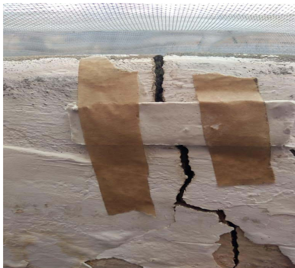
Figura 8 – Monitoramento através de plaquetas de gesso.
