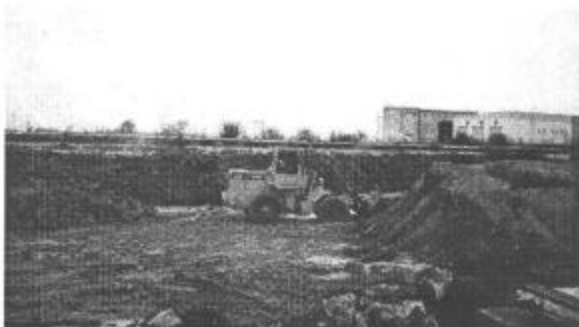
Foto 6 – Pá mecânica misturando solo poluído.
