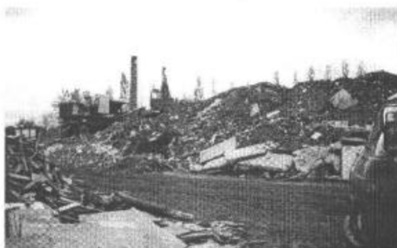
Foto 11 – Área de recebimento de escombros da indústria da construção.
