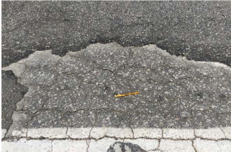
Figura 7 – Defeito do tipo buraco localizado na Faixa 2 do trecho estudado
