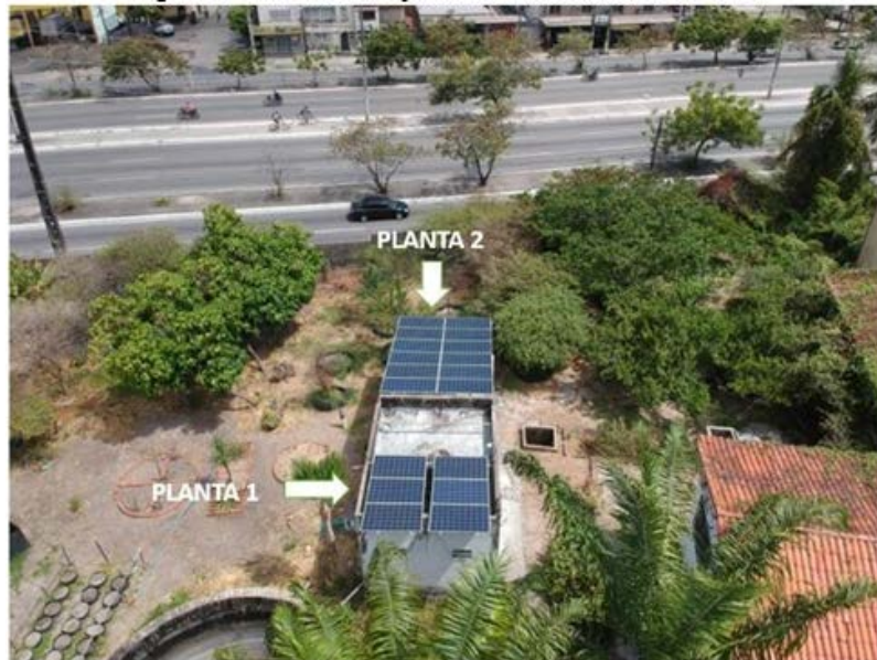
Figura 2 – Visão aérea das plantas FV instaladas no LEA – UFC.
