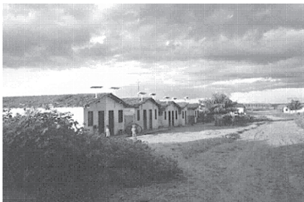
Figura 3: Sistemas fotovoltaicos em casas geminadas no município de Pentecoste-CE.
